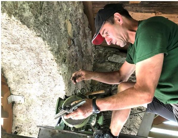
beim großen Führungsrad, es müssen Beilagscheiben unterlegt werden um einen schönen Kettenverlauf zu garantieren, läutet die große „Dreifaltigkeitsglocke“ wieder einwandfrei.
