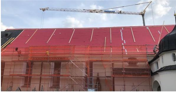
Damit das Dach auch sicher wasserfest wird, werden Bahnen mit Dachpappe auf die bestehende Schalung gelegt mit Nägeln befestigt und teilweise verklebt. Erst dann kommt der Spengler mit seinen neuen Kupferbahnen, mit denen er das Dach wieder belegt. Zuerst müssen aber noch die neuen Dachrinnen befestigt werden, um den Ablauf des Regenwassers zu garantieren.
