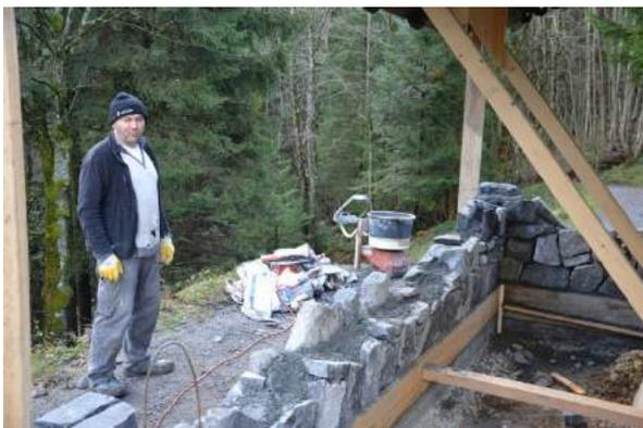
Am Kapellendach sind durch sich herauslösenden Lärchenschindeln Schwachstellen entstanden. Ende Oktober 2014 wird die Kapelle mit Alaska Zedernholzschindeln neu eingedeckt. Die bestehende Mauer im Vorhof der Kapelle und der Boden wird abgerissen und durch eine mit Beton gefüllte Natursteinmauer mit Kalksteinen aus dem Steinbruch Mellau ersetzt. Das Innere und Äußere der Kapelle wird, wo es notwendig ist, ausgebessert, abgebeizt und mit atmungsaktiver Kalkfarbe neu ausgemalt.
