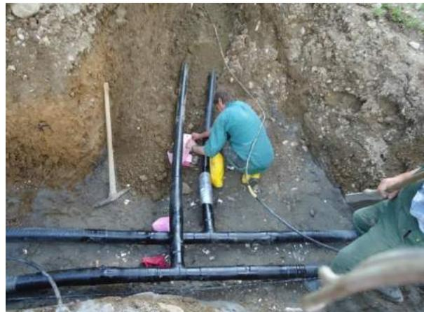
Zu diesem Zwecke müssen 1.270 Meter Rohre mit einem Durchmesser von 25-88 mm vom Haus Nr.261, ehemals Gasthaus Engel, bis zum Haus Nr.287 verlegt werden.
