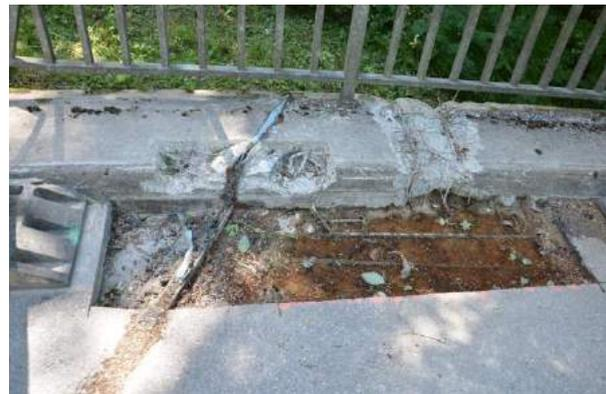
Abdichtung der Brücke mit Bitumen, Erneuerung der Fahrbahnübergänge (neue Dehnfuge zwischen Straße und Brücke) müssen bewerkstelligt werden. Die Randleiste soll zu einem Gehsteig verbreitert werden, um die Befahrung mit einem Kinderwagen zu ermöglichen. Das anfallende Oberflächenwasser der Brücke muss besser abgeleitet werden und ein Korrosionsschutz an der Armierung der Brücke wird angebracht. Den Abschluss der Arbeiten bildet die Anbringung eines neuen Asphaltbelages.
