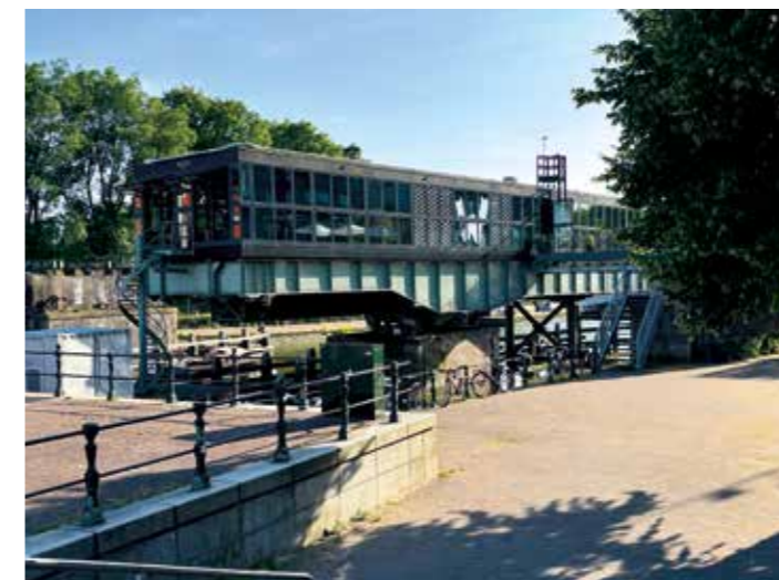
Das WOLF Atelier thront auf einer alten Eisenbahnbrücke und bietet einen traumhaften Blick über das Wasser in Amsterdam.
