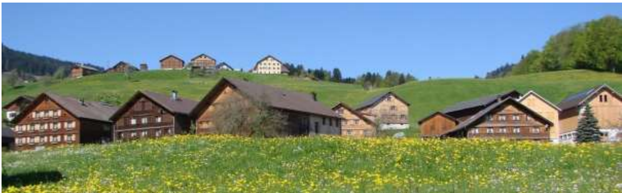
Abb. 3: Weiler Freien und Beien, die intakte orts- und landschaftsbildliche Gebäudesituierung mit Firstrichtung quer zum Hang und einheitlicher Fassadengestaltung - eine ortsbildliche Besonderheit von Schwarzenberg
