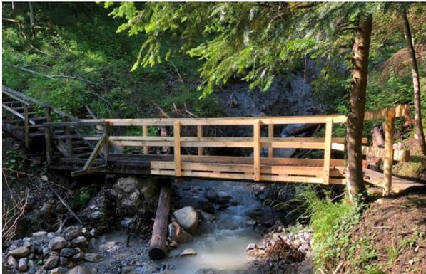
Bei der ersten Brücke im Beientobel werden die Lager und Befestigungen immer wieder unterspült, ein endgültiges Rezept für einen finanziell erschwinglichen Übergang wird es an dieser Stelle wohl nie geben. So reparieren Marc und sein Team diese Brücke zum x-ten Mal. Neue Dielen werden mit Betongitter belegt, ein Holzgeländer und eine Erneuerung der Seilaufhängung geben dem Bauwerk wieder neuen Halt.
