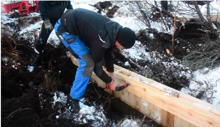
entwickelt. Im Einverständnis mit der Grundeigentümerin, der Agrargemeinschaft Otto Hämmerles Erben, soll durch den Einbau von Holzspundwänden und Torfstauen das Wasser zurückgehalten werden. Damit wird die schleichende hydrologische Verschlechterung unterbunden und neues Torfwachstum ermöglicht.
