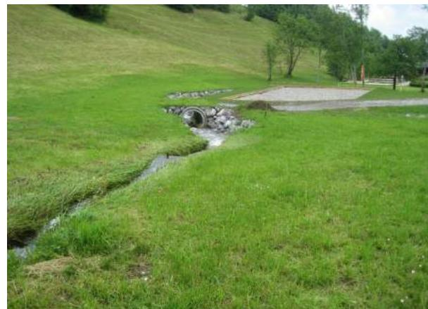
Verschiedene Ein- und Auslaufwerke mit Wasserbausteinen sichern die Böschungen.
