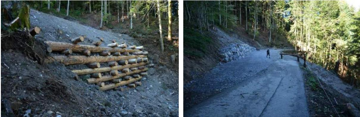
Im September wurde das Teilstück der Straße auf den Klausberg von der Firma Rüf aus Au neu gebaut. Als Hangsicherung mussten einige Tannen und Fichten erhalten, um eine „Kraierwand“ zur Sicherung des Hanges zu errichten. Die Aufschüttung hinter der Sicherung aus Holz erfolgte mit wasserdurchlässigem Kies.
