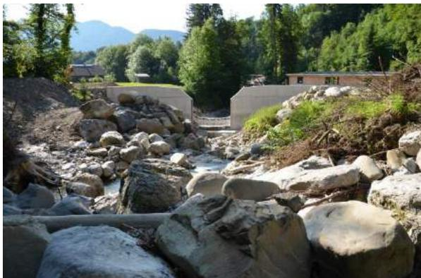
550 Kubikmeter Beton und 20 Tonnen Stahl sollen das Gewerbegebiet Dorn, die ARA Schwarzenberg, die Säge, das Gasthaus Mühle und die Brücke der Landesstraße, vor Hochwasser schützen. Im Juni wurde die 35 Meter breite und acht Meter hohe Hauptsperre fertig. Geschiebmaterial kann sich in einem Stauraum mit 13.500 Kubikmetern Fassungsvermögen ablagern.
